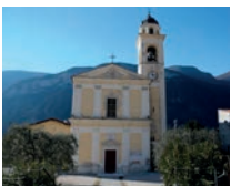
Chiesa di Ossenigo riedificata nella seconda metà del XVIII sec. Rebuilt in the second half of the XVIII century.
